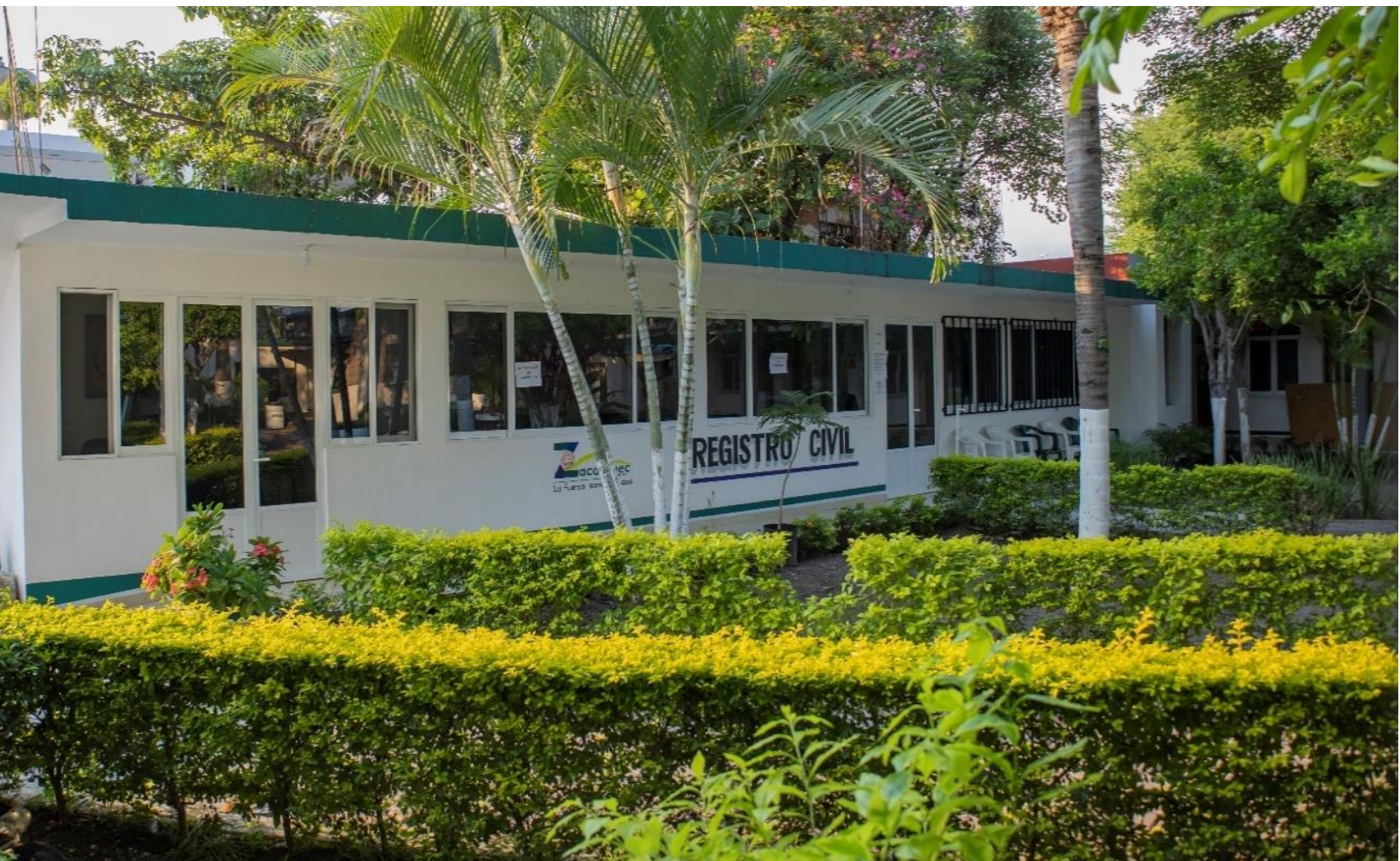
Construcción y Rehabilitación Oficinas del Ayuntamiento
