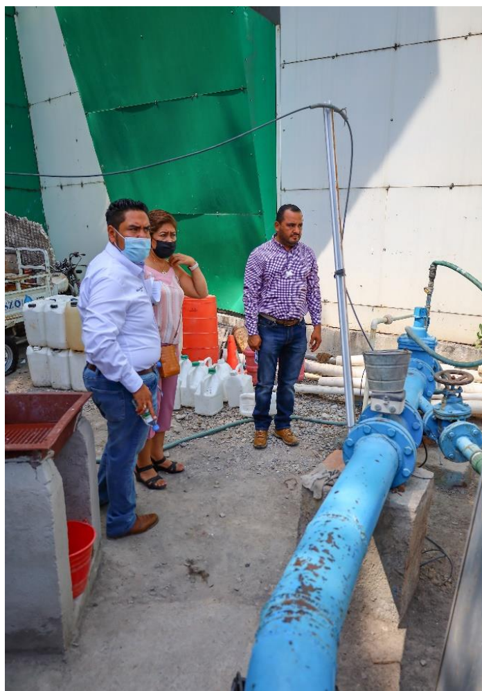
Sustitución y mantenimiento de válvulas
