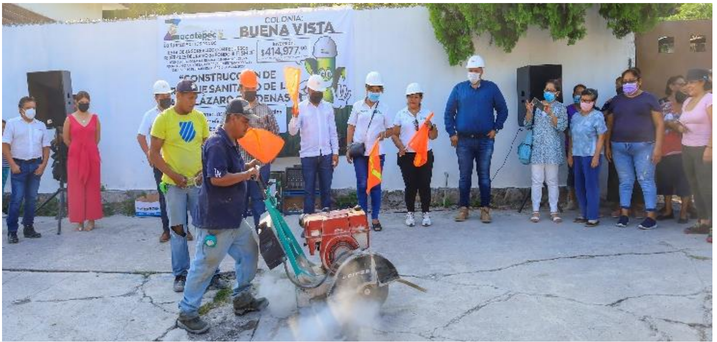
Construcción de drenaje sanitario de la Calle Lázaro Cárdenas
