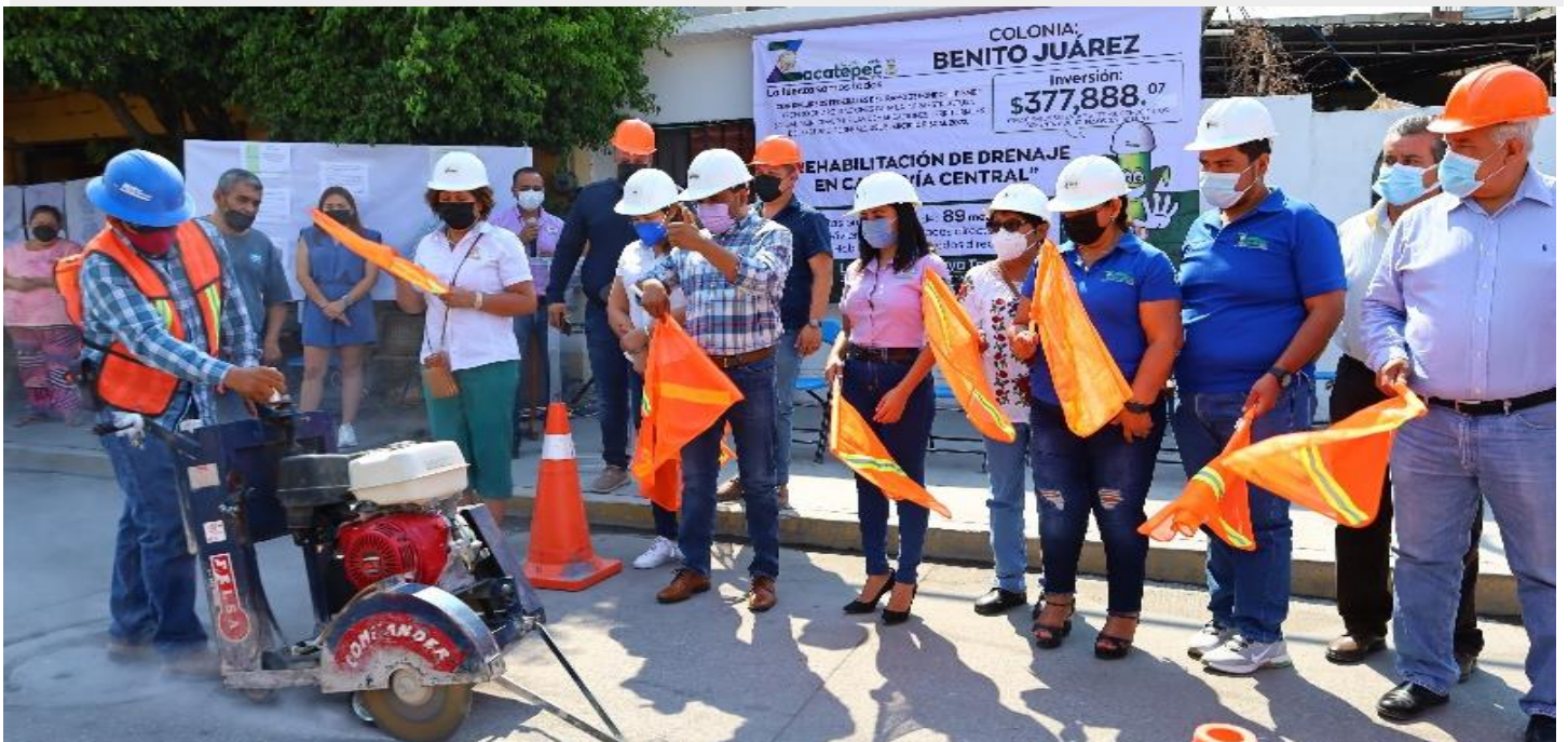
Rehabilitación de drenaje en calle Vía Central, Colonia Benito Juárez
