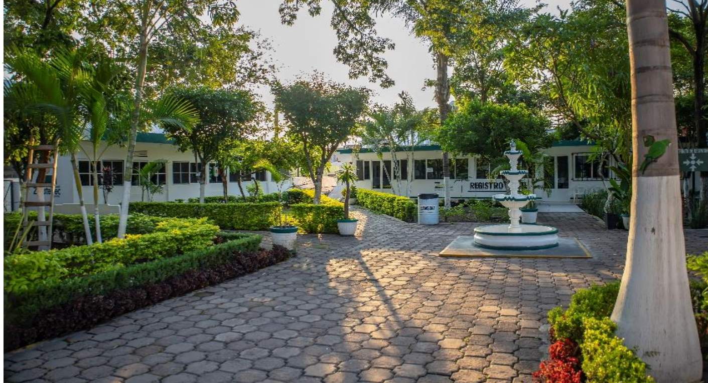
Construcción y Rehabilitación Oficinas del Ayuntamiento
