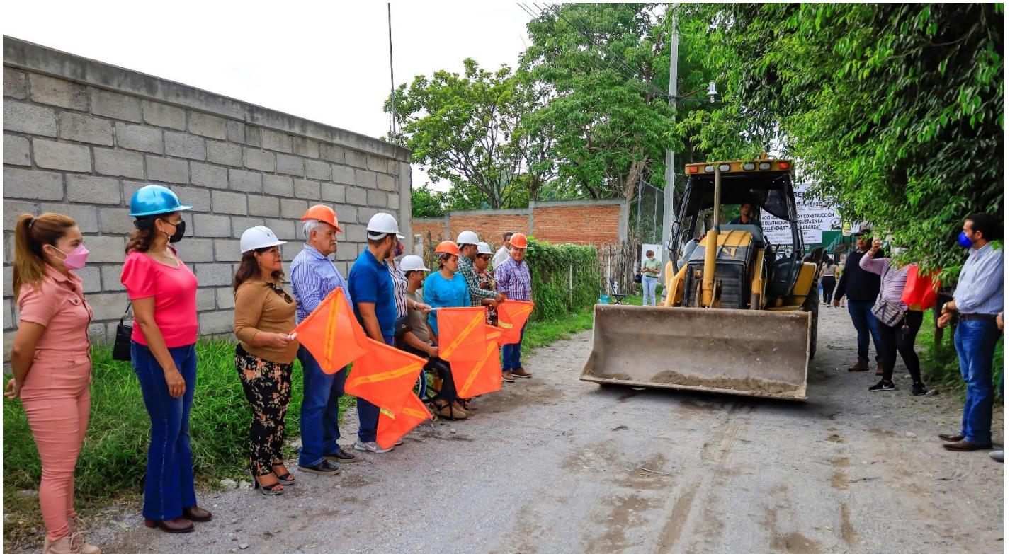
Ampliación de pavimento y construcción de guarnición y banqueta en Calle Venustiano Carranza, Colonia Benito Juárez
