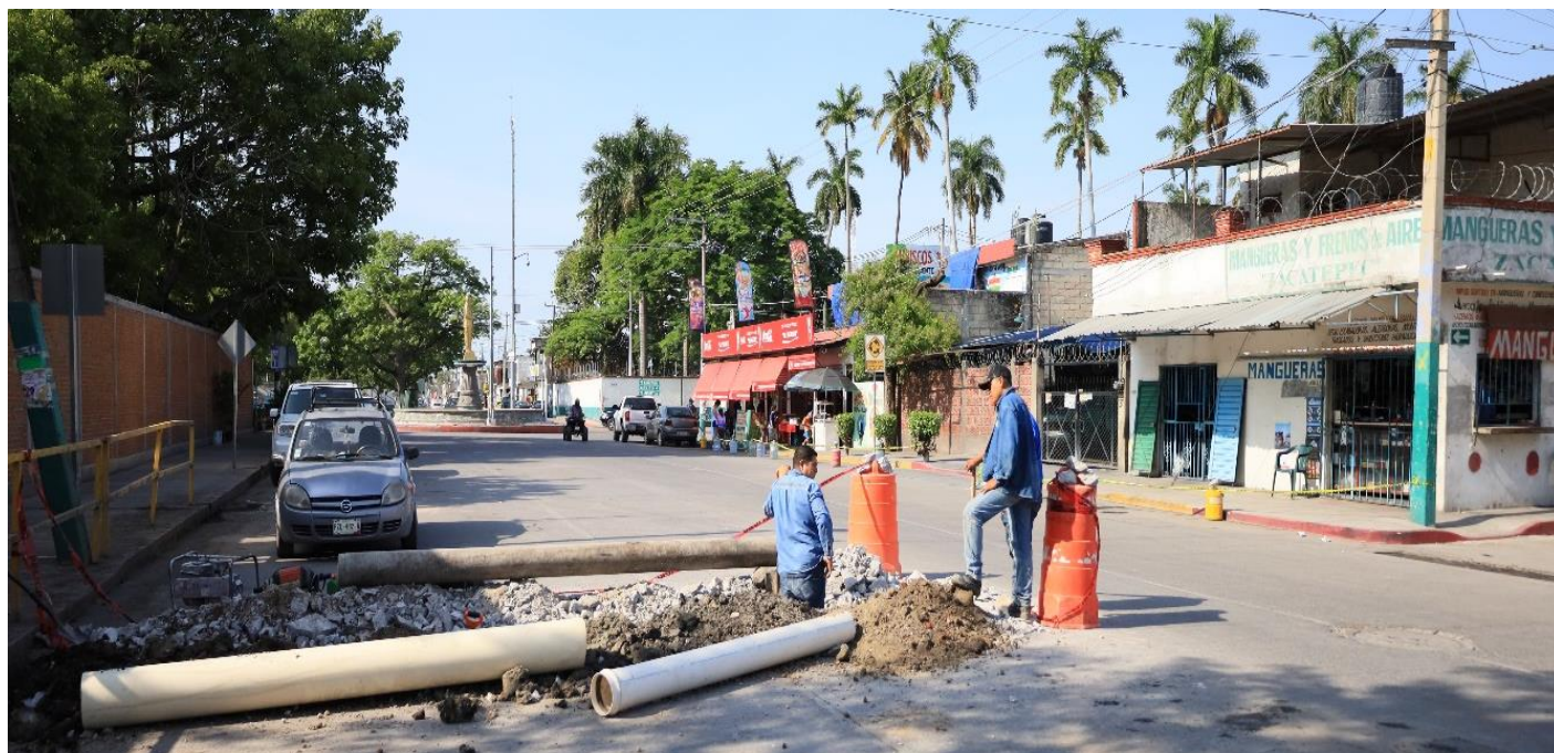
Sustitución de tuberías de drenaje en calle Ingenio Sanalona
